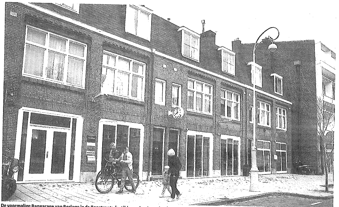
De voormalige Bangarage van Berlage in de Banstraat: destijds symbool van de Nieuwe Tijd.
